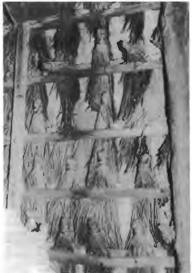
Abbildung 2: **Unterseite eines ca. 100 Jahre alten Hohlpfannendaches mit Strohdocken. Spuren von ablaufendem Tauwasser sind unter den Hohlpfannen erkennbar (Bauernhaus in Groß Schwülper/Niedersachsen)**
