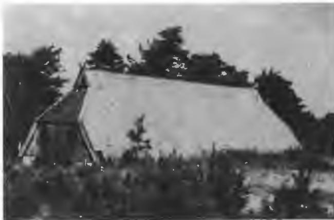
Abbildung 1: **Alter, nicht-wärmegeämmter Schafstall in der Lüneburger Heide, Dacheindeckung: Hohlpfannen, trocken verlegt, ohne Docken**
