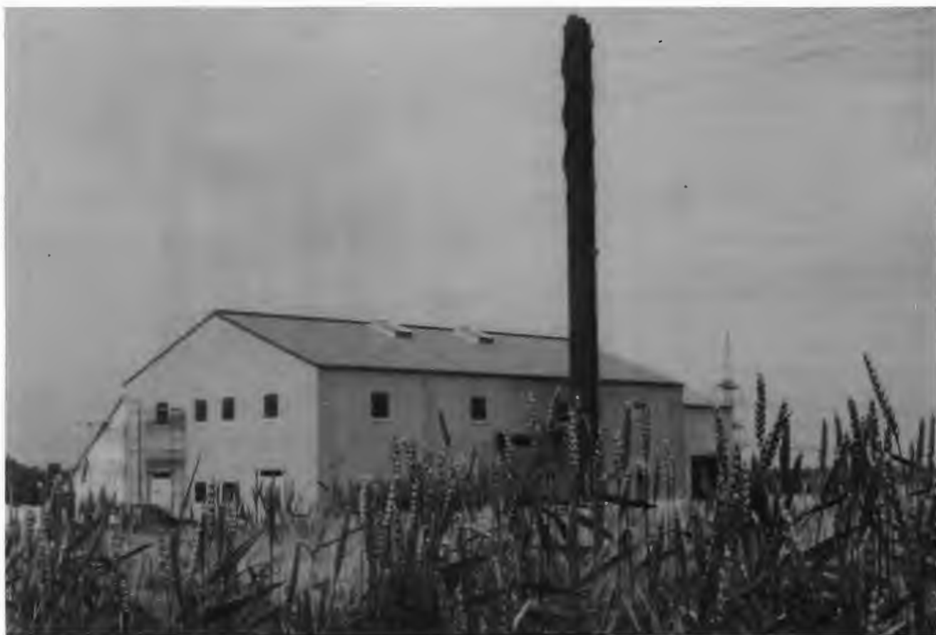
Abbildung 12: Die erste Anlage in Deutschland zur Erzeugung von Wärme aus Biomasse (Festbrennstoffe, vorwiegend Stroh) wird Ende 1993 in Schkölen bei Jena in Betrieb gehen. Die Leistung des Biomasseheizwerkes beträgt 3,15 MW.
