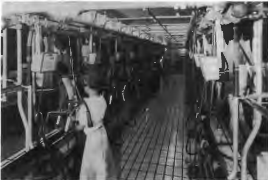
Bild 9: Zu jedem Milchvieh-Laufstall gehört ein Melkstand. Die verschiedenen Bauarten unterscheiden sich in der Positionierung der Kühe zum Bereich des Melkers
