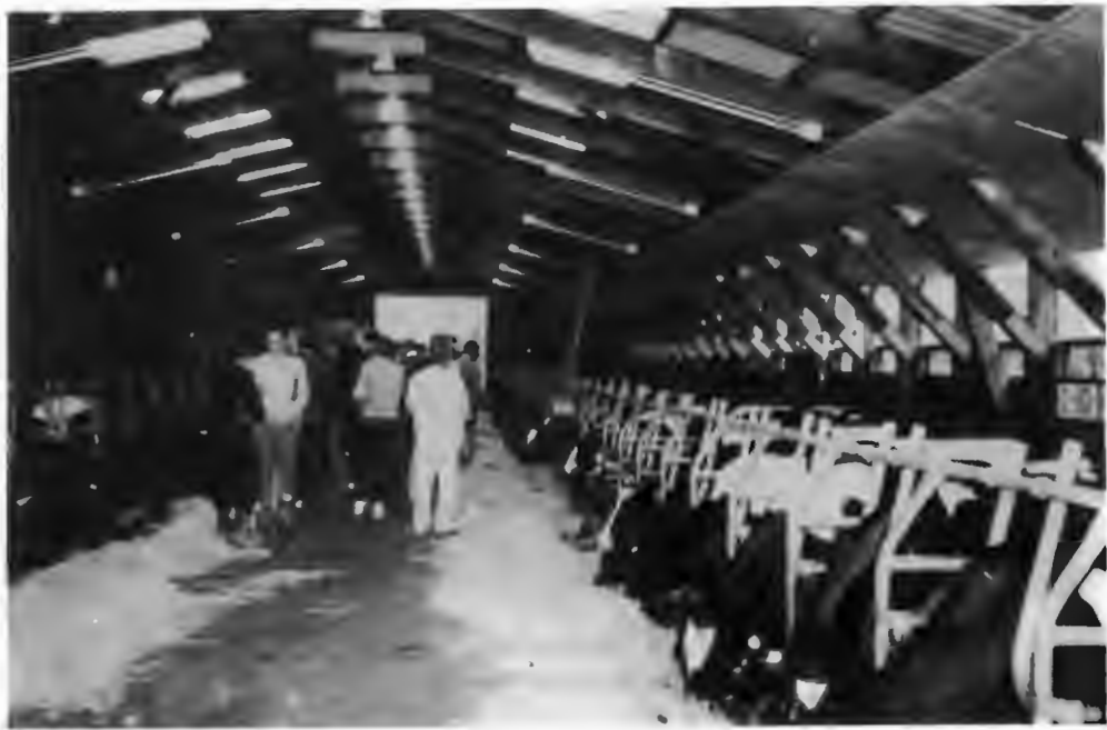
Bild 1: Freß-Liegeboxen-Laufstall für Milchkühe. Gebäude mit Traufen-Firstlüftung (natürliche Ventilation)
