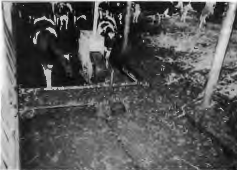
Bild 13: Tretmiststall. Der befestigte Boden im Bereich des Strohlagers wird mit einem Gefälle versehen. Durch das Einstreuen auf der Bergseite und durch das Laufen der Rinder zum Freßplatz verstärkt sich dieses Gefälle. Der Laufgang am Freßgitter soll mehrmals täglich gereinigt werden, z.B. mit dem Auto-Dungschieber in Verbindung mit Freßständen (16)
