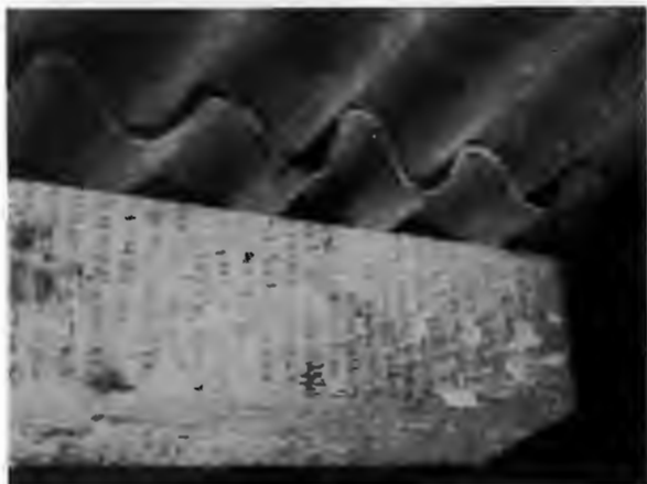
Bild 8: Angehobene Dachplatten gewährleisten eine gute Durchlüftung der ungedämmten Ställe. Eine Standardempfehlung bei Neu- und Umbauten in der Rinderhaltung
