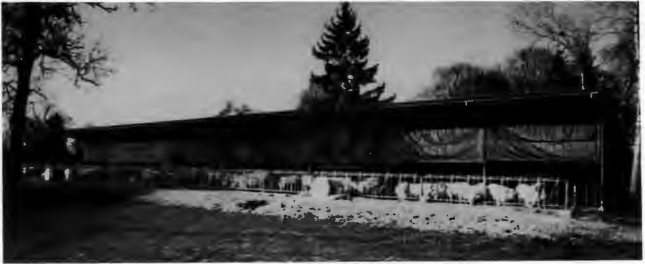
Bild 2: Ungedämmtes Gebäude für Mastrinder, Liegefläche mit Stroh eingestreut. Offene Gebäudeseite Süd/Südwest. Windnetze reduzieren die Luftgeschwindigkeit im Liegebereich
