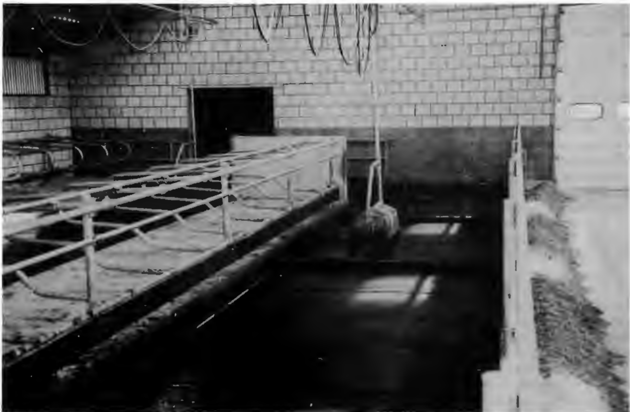
Bild 15: Neue Entmistungstechniken in Verbindung mit einer schnellen Entwässerung (Jaucheabfluß) der Laufflächen stellen eine tiergerechte Alternative zu den mit Spaltenböden ausgeführten Laufgängen dar. Fahrgeschwindigkeit ca. 3 m/Min.
