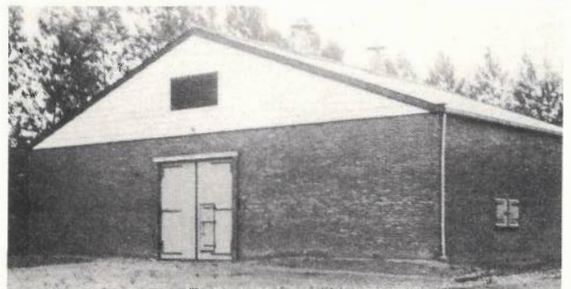
Abb. 5b: Neuester Typ; die Zuluftklappen liegen in der Aussenwand etwa 1 m über dem Boden, Luftabfuhr erfolgt durch Öffnungen im Giebel und im First.
