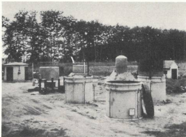
Drei Methanganlagen verschiedener Systeme auf dem Gelände des Instituts für Humuswirtschaft.
