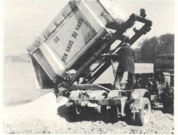
Abb. 2: Die Bundesbahn bringt Kalkbehälter mit Spezialfahrzeugen bis auf das Feld. Hier wird Branntkalk entladen.
