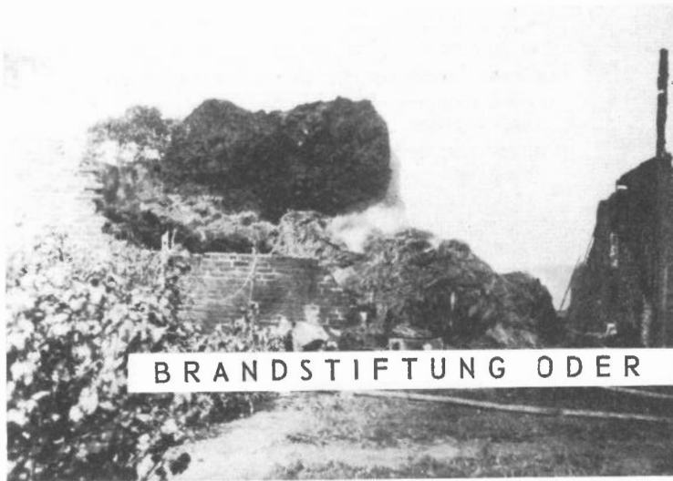
Abb. 1 Unverbrannter Heustapel nach der Ein- äschung des Gebäudes.
