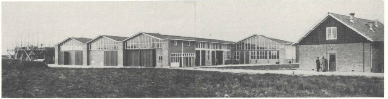
Neubau der Institute für Landtechnik und Gartenbautechnik in Wageningen.
