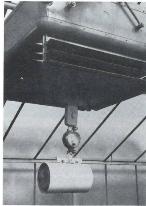
Abb. 8: Das Gea-Therm-Gerät für die Lufterhitzung und Meßeinheit mit den Meßwertgebern für Temperatur und Luftfeuchte
