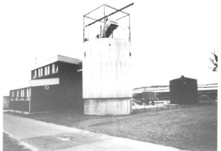
Bild 7: Versuchsbio gasanlage mit 100 m 3 Faulraumvolumen zur Erstellung von Biogas aus Rest- und Abfallstoffen
