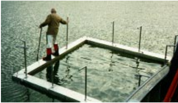
Abb. 10 : Montage der Seezaunstützen
