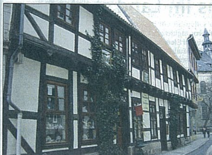
Fachwerkhäuser in Quedlinburg: Häuser auf Steinsockel (baulicher Holzschutz) mit auskragendem Obergeschoss und zu geringem Dachüberstand in Quedlinburg
