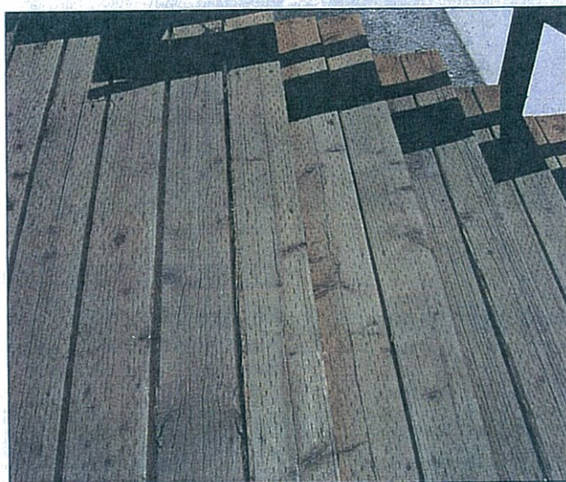
Abbildung 3 Mechanische Vorbehandlung („Incising“) von Douglasie in den USA
