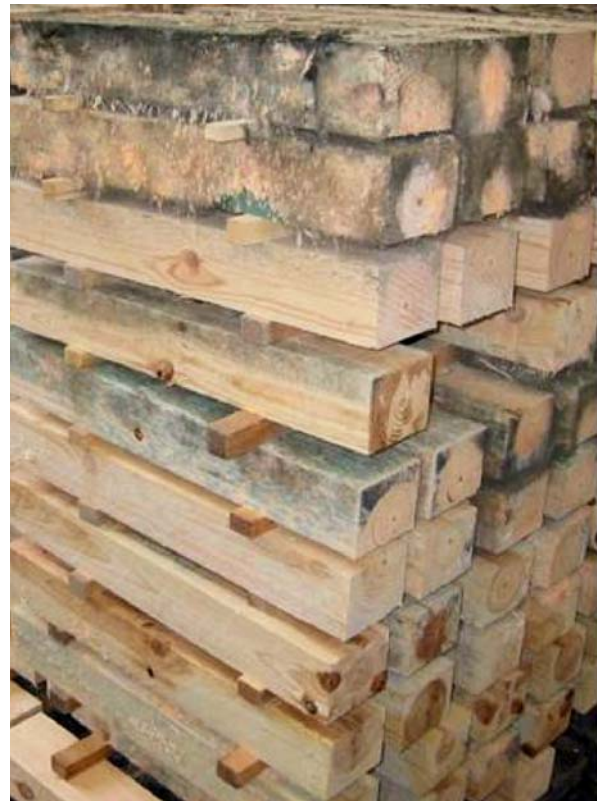
Abb. 3: Schadbilder hitzebehandelter Proben nach zweiwöchiger Lagerung unter Folie. Obere beiden Reihen ohne zusätzliche Behandlung; darunter liegende Reihen mit verschiedenen Substanzen behandelt.
