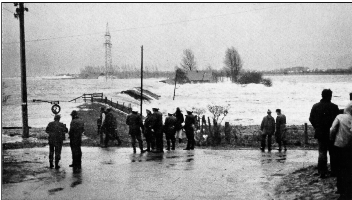
Abb. 10.5 Deichbrüche bei Holm/Haseldorfer Marsch am 03. Januar 1976 (max. eingeflossene Wassermenge rd. 6000 m 3 über 30 Min. bei Fallhöhen von 3,6 m bis 4,5 m) nach CARSTENS, 1976.
