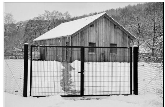
Bild 9: Die geschlossene Kläranlage von Mörshausen
