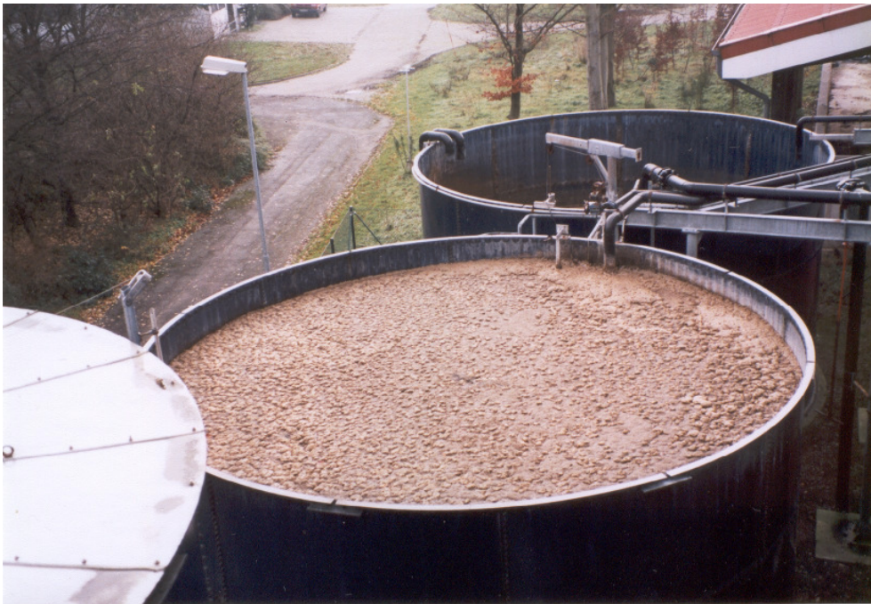
Abb. 14: Schwimmende Abdeckung auf Kunststoff-Erdbecken Natural swimming layer from cattle slurry solids in a bio-gas plant
