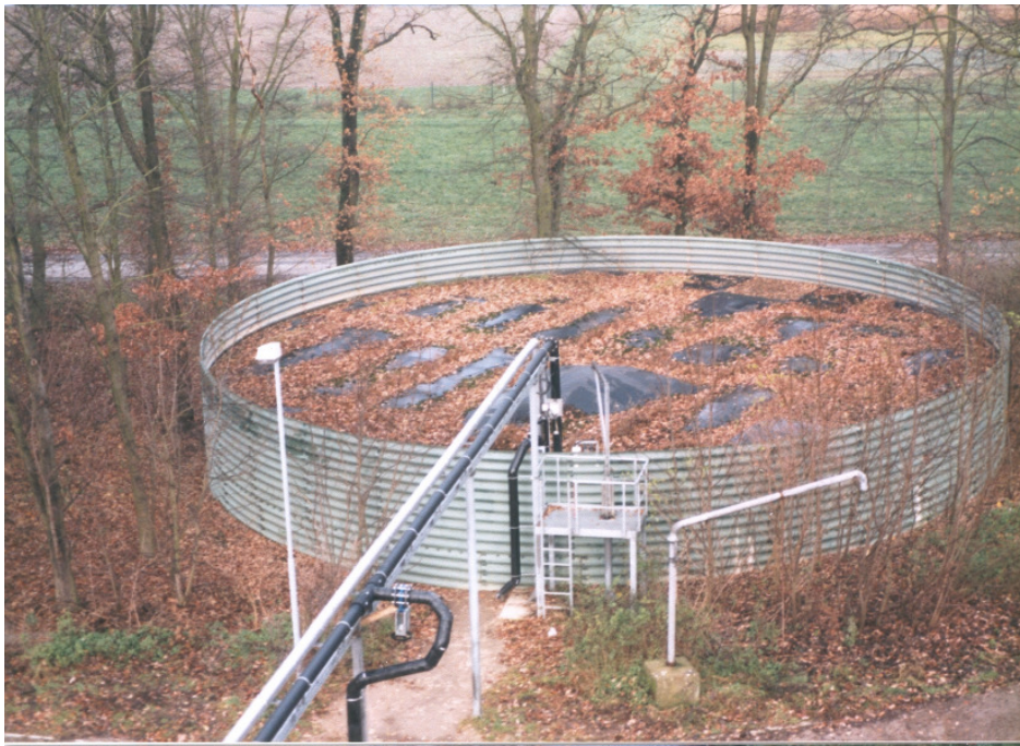
Abb. 16: Schwimmende Kunststoffdecke auf rundem Stahlbehälter für Gülle Plastic swimming layer on a round steel container for slurry
