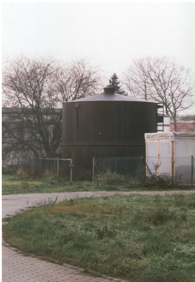
Abb. 17: Stahldeckel auf rundem Stahlbehälter einer Biogas-Anlage Steel cover on a round steel container in a bio-gas plant
