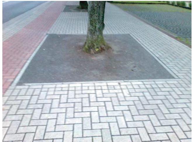
Abb. 3. Baumspiegel mit Hansegrand Münstergelb in Bau nicht abgerüttelt (3a, links) und Baumspiegel mit Grazit PZ 0/5 (3b, rechts).
