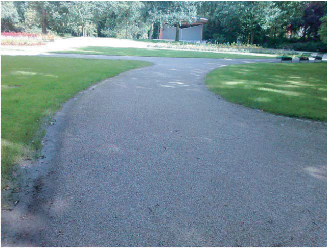
Abb. 4. Wegefläche mit Moränesplitt 0/5 (4a, links) und Pflasterfläche mit Splitt bestreut und abgefegt (4b, rechts).
