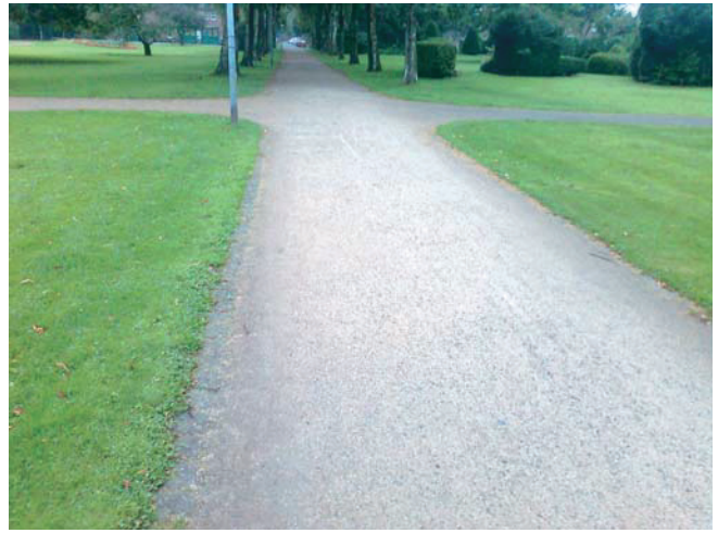
Abb. 2. Wegedecke mit Deckenmaterial Dolomitbrechsand, Einfassung aus Natursteingroßpflaster.
