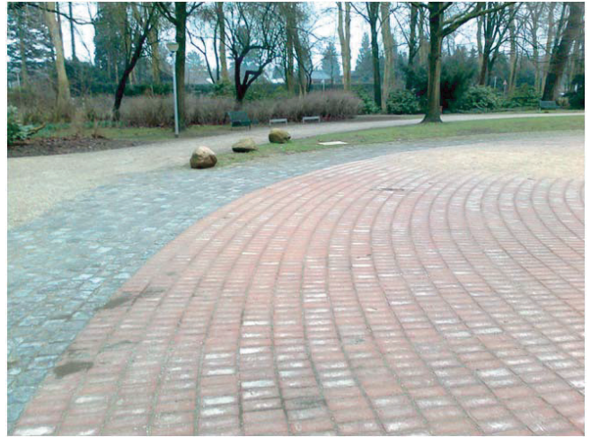
Abb. 4. Wegefläche mit Moränesplitt 0/5 (4a, links) und Pflasterfläche mit Splitt bestreut und abgefegt (4b, rechts).
