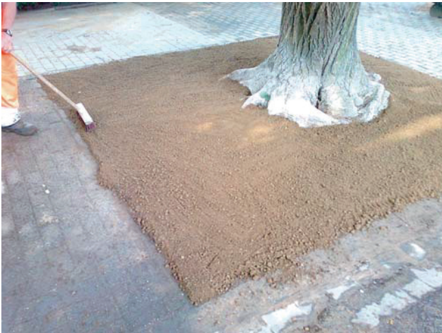
Abb. 3. Baumspiegel mit Hansegrand Münstergelb in Bau nicht abgerüttelt (3a, links) und Baumspiegel mit Grazit PZ 0/5 (3b, rechts).
