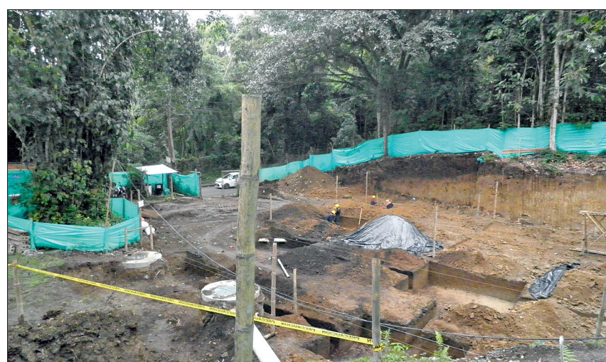
Abbildung 6 Baugrube für die Fundamente des Technik-Gebäudes
