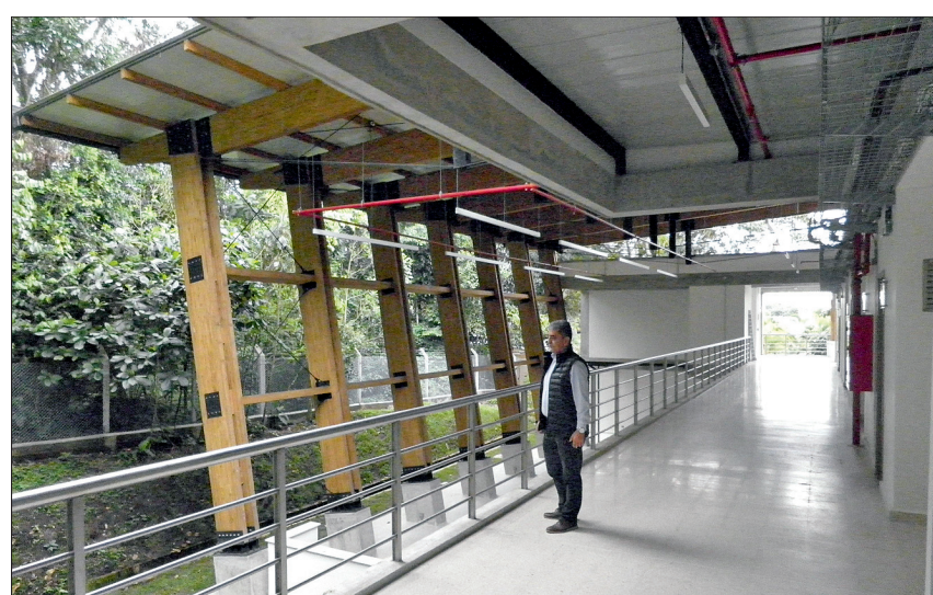
Abbildung 5 Detailansicht des Dachtragwerks
