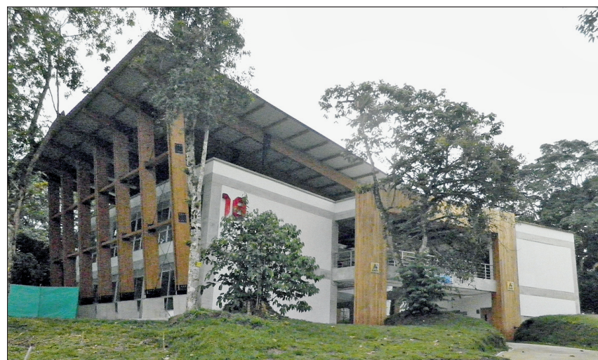
Abbildung 4 Labor- und Bürogebäude mit übergestülptem Dach in Holzleimbau-Konstruktion
