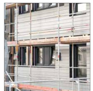
Eine Strangsanierung vermeiden und die Versorgung der Wohneinheiten über die neu errichtete Fassade herstellen: Dafür haben die Fischbach-Gruppe (links) mit einem unterirdischen zentralen TGA-Modul und der Versorgung der einzelnen Wohnungen über „Backpacker“-Stränge in der Fassade und Ecoworks (rechts) mit fassadenintegrierten TGA-Modulen zwei unterschiedliche Varianten entwickelt. Fotos: Dena/Jörg Parsick-Mathieu (3)
