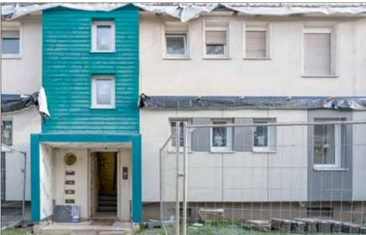
Die Saint-Gobain-Tochterfirma Pre-Formance hängt die Fassadenbauteile mittels eines speziellen Befestigungssystems direkt an der Bestandsstruktur an und kommt so ohne Fundament und Montagegerüst aus. Dena/Jörg Parsick-Mathieu
