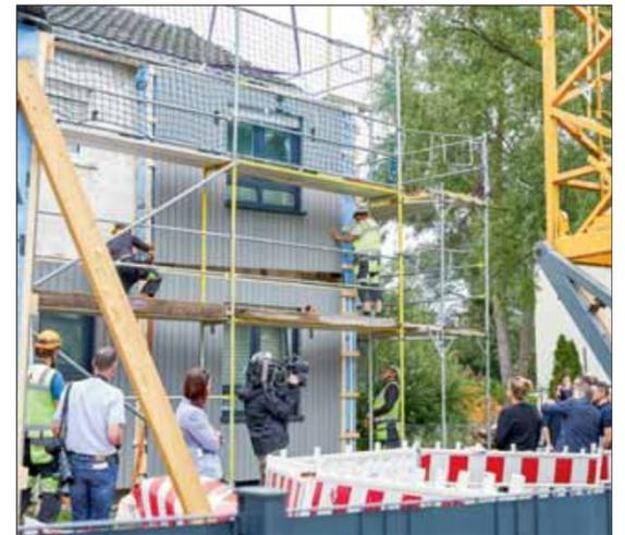
Alle 19 Gebäude des Sanierungsprojekts werden mit industriell vorgefertigten Fassaden-, Dach- und Technikmodulen auf die Energieeffizienzklasse 55 EE gedämmt bzw. auf den klimaneutralen Net-Zero-Standard gebracht. Hier eine Baustelle der Firma Renowate, ein Joint-Venture der LEG mit dem Bauunternehmen Rhomberg. Foto: LEG/Peter Weihs
