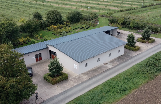
Abb. 1. Betriebsgebäude der Lochwald-Riednuss GbR
