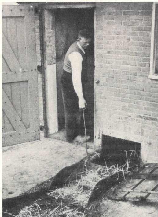
links: Entmüsstungsanlage mit Seilzug und Rückführung von Hand.
