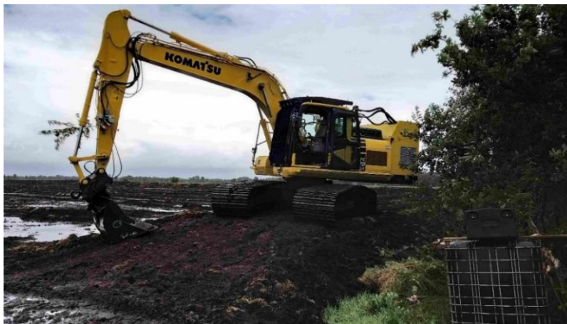
Foto A/13: Der Hydraulikbagger im Einsatz bei der Herstellung der Verwallungen im Tannenhäuser Moor (Quelle des Fotos: Niedersächsische Moorverwaltung, Februar 2020)
