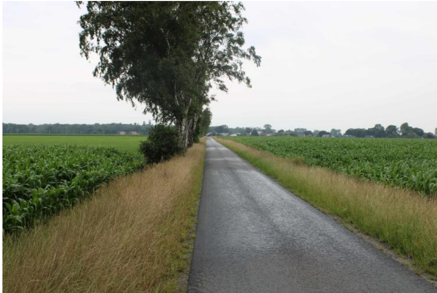
Foto A/1: Der neu ausgebaute Norddahrer Kirchweg (Aufnahme: Thünen-Institut/Bathke, Juli 2020)
