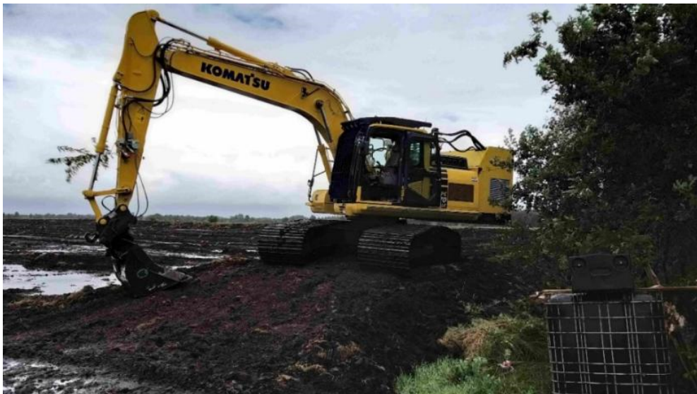
Foto 3: Hydraulikbagger im Einsatz bei der Herstellung der Verwallungen im Tannenhäuser Moor
