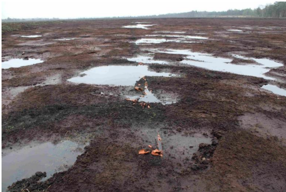
Foto A/16: Abtrag des Oberbodens bis auf die Höhe der früheren Drainagen im Bereich des Vernässungsgebietes TG02 (Aufnahme: Thünen-Institut/Bathke, Dezember 2020)
