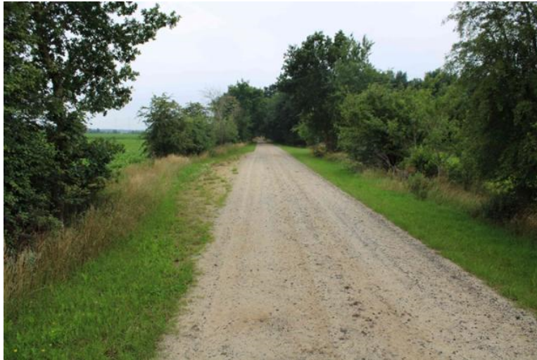
Foto A/7: Ausgebaute Schotterstrecke im Knüllensmoor (Aufnahme: Thünen-Institut/Bathke, Juli 2020)
