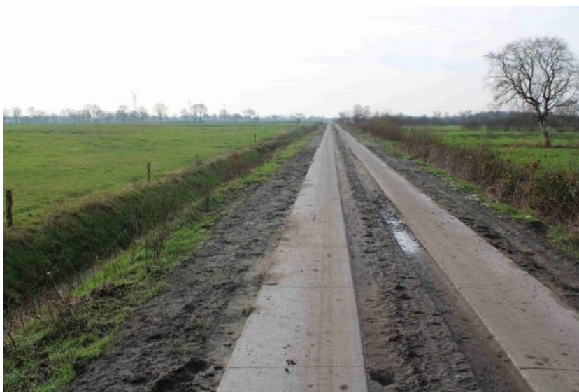
Foto A/9: Der als Beton-Spurbahn ausgebaute Stickerspittweg kurz nach der Fertigstellung (Aufnahme: Thünen-Institut/Bathke, Dezember 2020)
