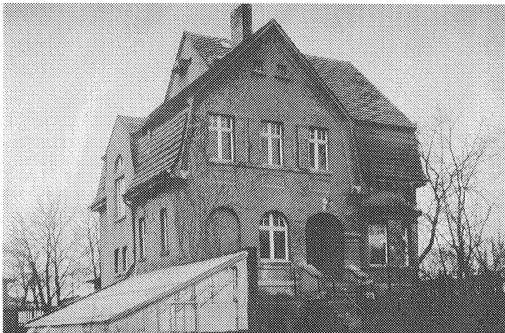
Abb. 3 Gebäude der Zweigstelle in der Ermslebener Straße 52
