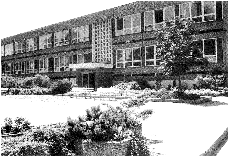
Bild 6: Neubau des Laborgebäudes I für den Bereich Pflanzenschutzmittelforschung (1977)
