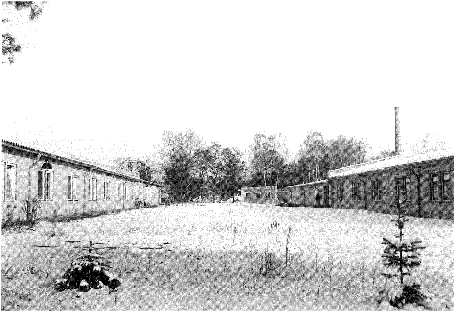
Bild 5: Flachbauten aus der Hinterlassenschaft des Autobahnbaubetriebes (Neubau des Grenzkontrollpunktes Drewitz). Nach dem Umbau wurden sie für Fachabteilungen (links), für die Verwaltung (rechts), für das Pflanzenschutzmittellager (hinten rechts) genutzt. Im Hintergrund das Begasungshaus.
