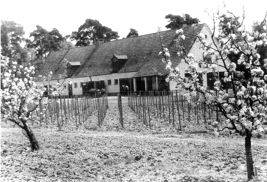
Bild 2: Versuchsfeld Kleinmachnow (Karl-Marx-Straße) - Teil der Obstanlage und Versuchsfeldgebäude.
