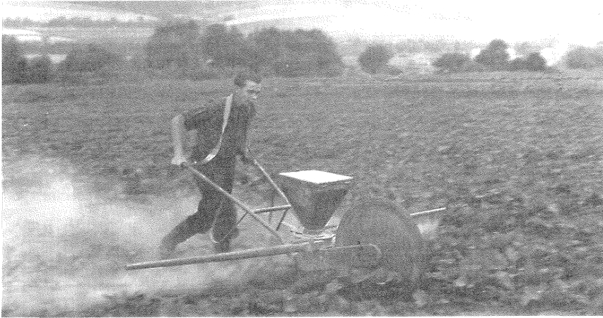
Bild 1: Das nach Kriegsende übliche Applikationsverfahren Stäuben ist mit den Nachteilen der schlechten Mittelanlagerung an den Zielflächen und starker Abdrift verknüpft.
