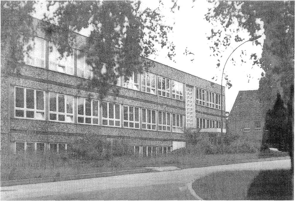
Laborgebäude des Bereiches Toxikologie
