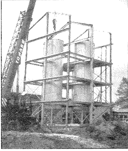
Bild 18: Errichtung der zwei 20 t - Stahlsilozellen im entstehenden heizbaren Silogebäude
