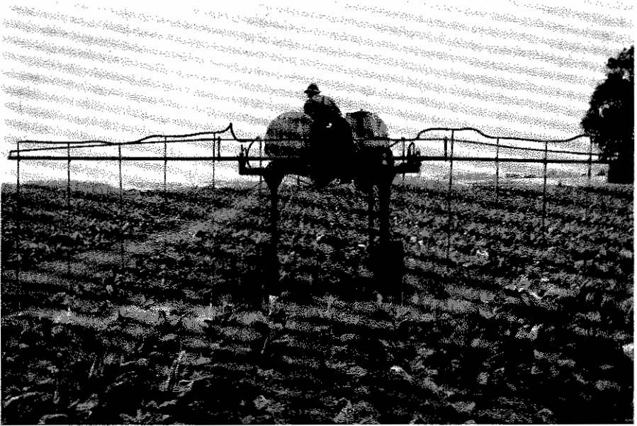
Abb. 30. Behandlung eines jungen Tabakbestandes mit dem „Schulze-Eckel“-Stelzengerät (Dralldüsen nur unten).
