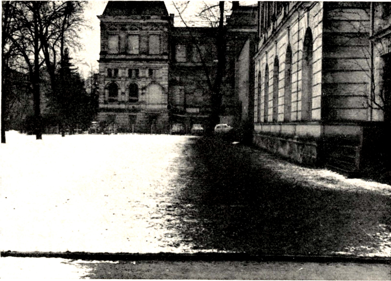
Abb. 1. Blick auf den schneefreien Heizungsstreifen, links die schneebedeckte, nichtbeheizte Wiese.
