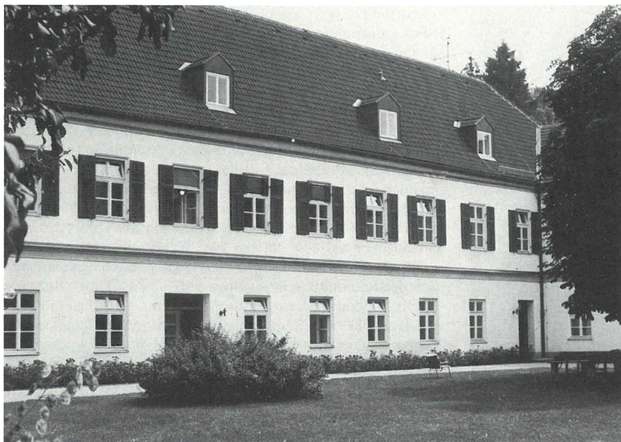
Das Gebäude des Instituts für Resistenzgenetik in Grünbach.
