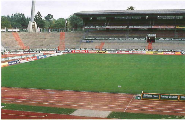
Abb. 1. Wildparkstadion in Karlsruhe. Von der Tribüne aus können die Schäden noch nicht wahrgenommen werden.
