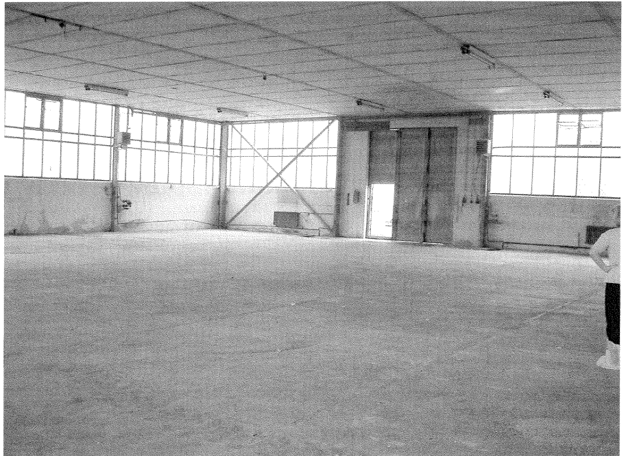
Abb. 1. Innenansicht des ehemaligen PSM-Lagers in Malchin (Juni 2002).
