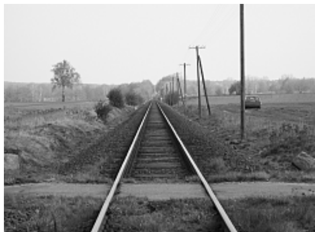
Abb. 2. Fahrstrecke des Spritzzuges in Richtung Wieren (Norden).
