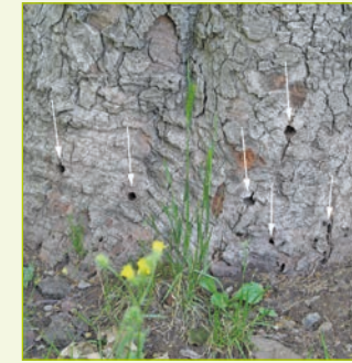
11. Kreisrunde Ausbohrlöcher am Stammfuß
