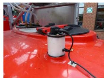
Abb. 17: Elektr. Füllstandsensor.
