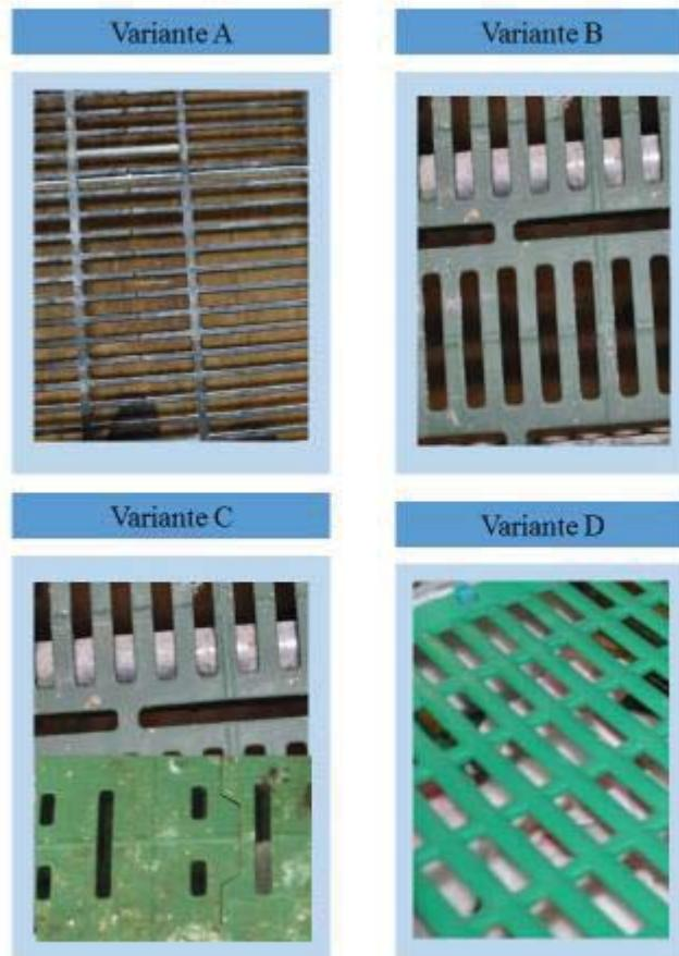
Abb. 2: Übersicht über die 4 untersuchten Fußbodenvarianten (A = Kunststofffroste mit 5 mm Auftrittsbreite und 13 mm Spaltenweite = Perforationsanteil 75 %; B = Kunststofffroste mit 10 mm Auftrittsbreite und 10 mm Schlitzweite = Perforationsanteil 50 %; C = Grundfläche wie B, erhöhte Ebene = Perforationsanteil 10 %; D = Kunststofffrost mit 12 mm Auftrittsbreite und 12 mm Schlitzweite = Perforationsanteil 50 %)
