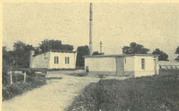
Abb. 7: Teil des Versuchsgeländes des Lehrstuhles für Pflanzenschutz
