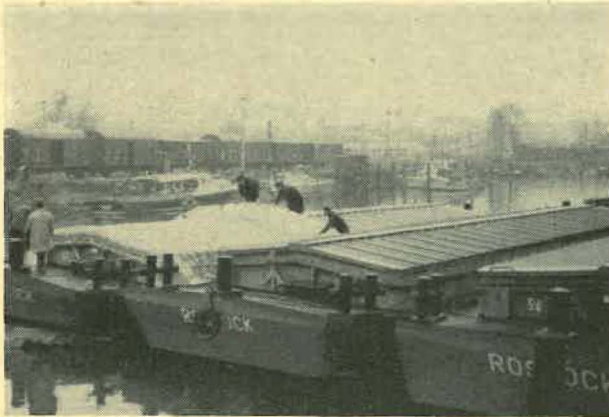
Abb. 9: Abdeckung einer Puntschute mit einer Polyäthylenplane
