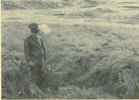
Abb. 7 Fot. Klemm Uferbeschädigung durch Bismarratten.
