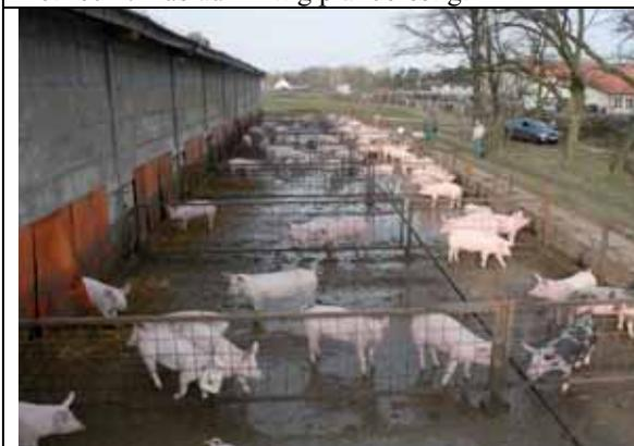
Betrieb 3: Auslauf planbefestigt, zu geringes Gefälle
