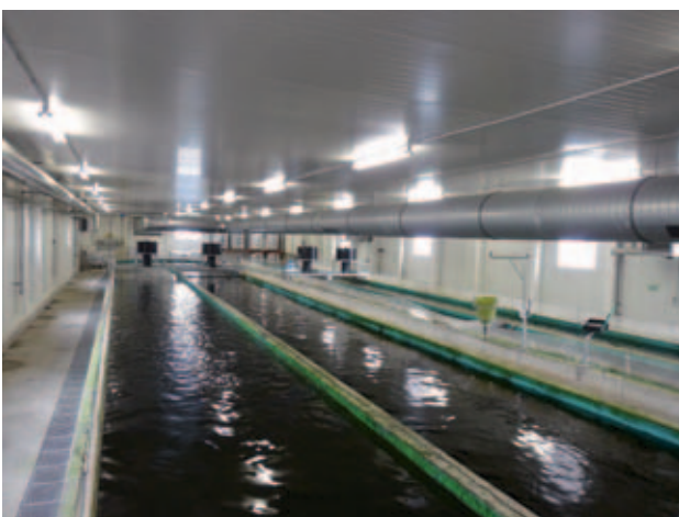
Abb. 3: Fließkanäle der Kaltwasserkreislaufanlage Hohen Wangelin
