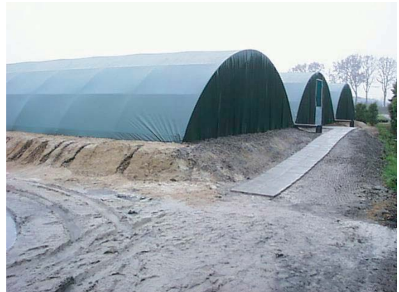
Abb. 5.4. Überdachung eines Reinwasserbeckens (Erd-Folien-Becken)
