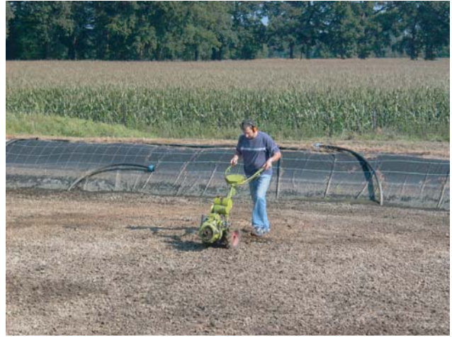
Abb. 7.2. Aufharken der "Schmutzdecke" mit dem Einachsschlepper
