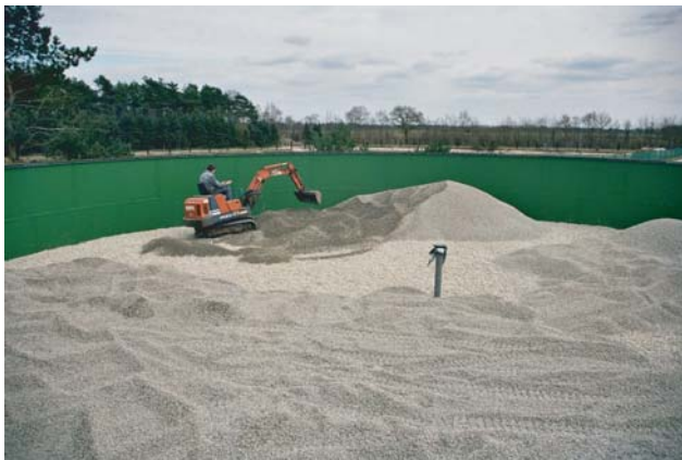
Abb. 2.5. Einbau der Drainageschicht (Bauart: Stahltank)
