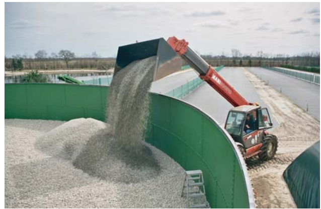
Abb. 7.4. Einfüllen des Filtersandes mit Hilfe eines Teleskopladlers
