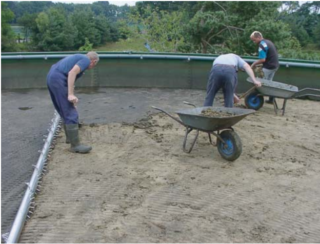
Abb. 7.1. Manuelles Schälen der "Schmutzdecke" (links: "Igelwalze")
