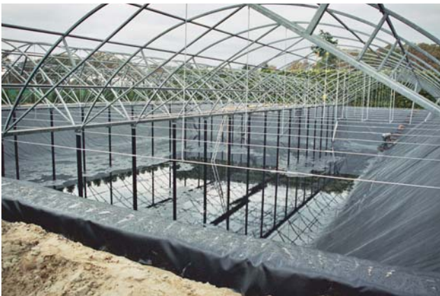
Abb. 5.3. Reinwasserbecken als Erd-Folien-Becken mit Bogendachkonstruktion (Bauphase)
