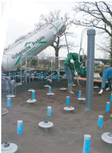
Abb. 3.3. Einfüllen des Lavagranulats
