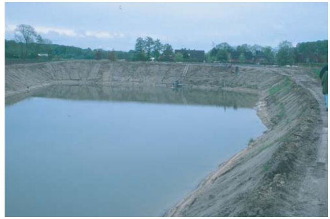
Abb. 5.2. Reinwasserbecken als offenes Erdbecken ohne Folieauskleidung
