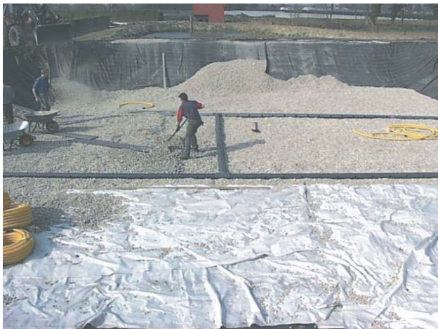
Abb. 2.3. Einbau der Drainageschicht
