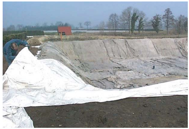
Abb. 2.2. Auslegen des Filterbeckens mit Stoffbahnen schützt die darauf folgende Teichfolie
