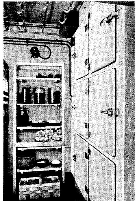
Abb. 5: Blick in den Kühlraum und auf die Türen der Schließfächer der Anlage in Binselberg (s. Bild 4)
