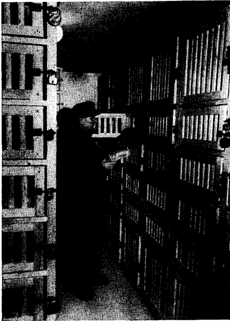
Abb. 2: Kaltraumanlage mit 76 Holz-fächern in Kirchbauna bei Kassel. Rechts oben ein Kaltluftkanal. Hersteller: Gesellschaft für Linde's Eis-maschinen AG., Maschinenfabrik Sürth, Sürth bei Köln.
