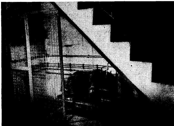
Abbildung 23: Kältemaschinensatz mit Wasserkühlung der Firma A. Teves, Frankfurt/M., aufgestellt in Mittelbuchen, Kreis Hanau. Der Verflüssiger ist durch den Kompressor verdeckt. An der Maschine vorn rechts der Kühlwasserregler.
