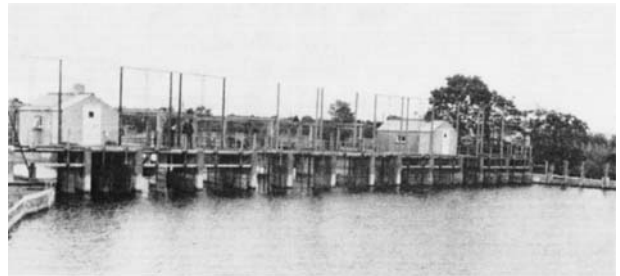
Abb. 4. Großfanganlage in dem Fluß Bann (Nordirland) Es wird der ganze Fluß abgesperrt. Der Fang der abwandernden Aale geschieht mittels Netzen, die hinter die Brückenpfeiler gesetzt werden
